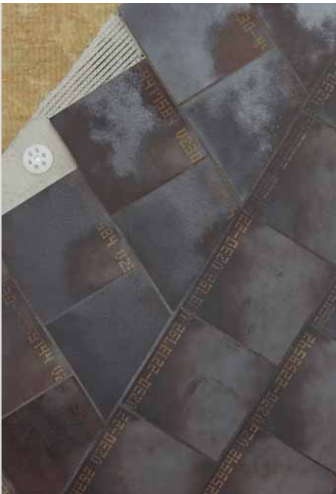
Shuttle Fassadenkeramik auf WDV-System
