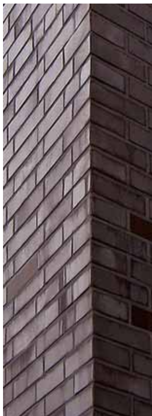
Eckwinkeln nach Winkelvorgabe angefertigt
