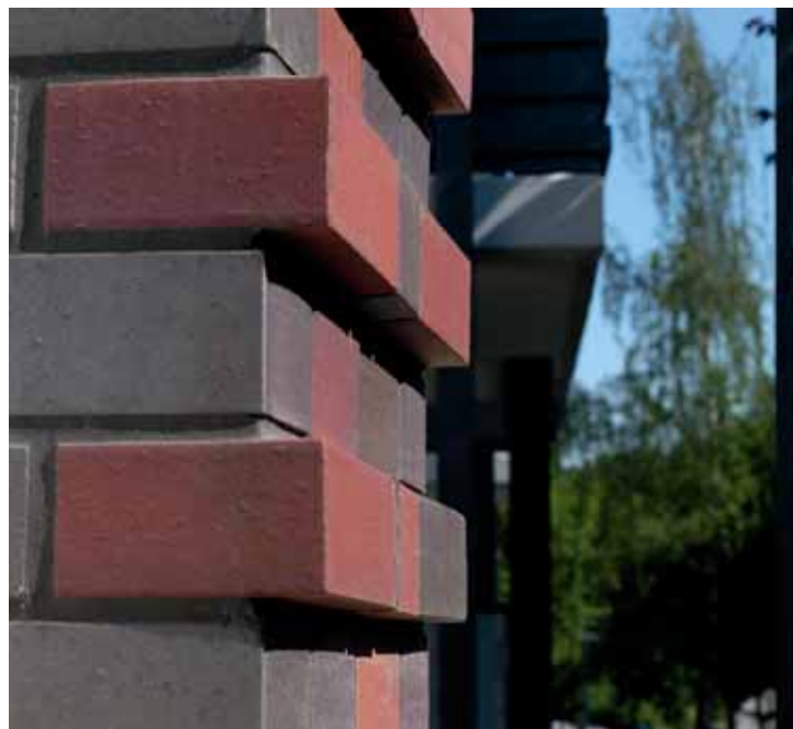
Gebäudeecke mit Gesimse, Buchsbaumweg Hamburg
